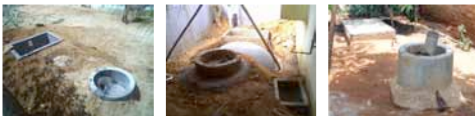
Χωνευτήρια για παραγωγή βιοαερίου
